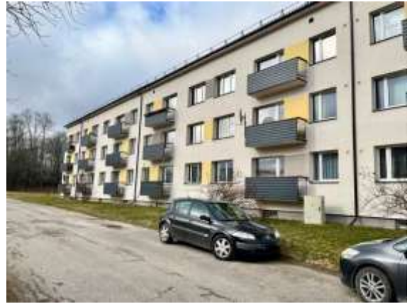
Daudzdzīvokļu dzīvojamās ēkas fasāde
