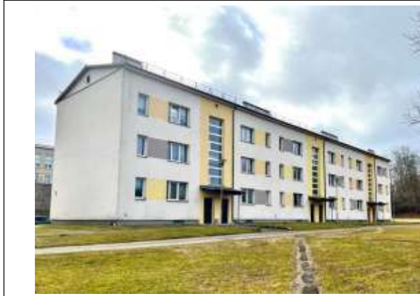
Daudzdzīvokļu dzīvojamās ēkas fasāde
